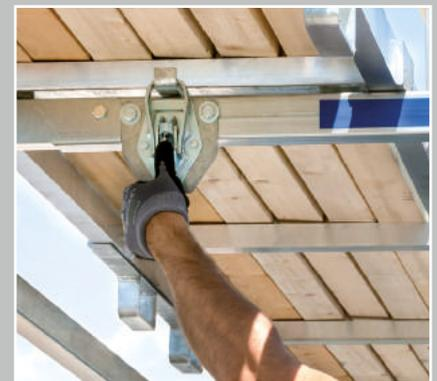
Schnellverschluss\* für die rasche Befestigung des LongRacks auf dem PowerRack
